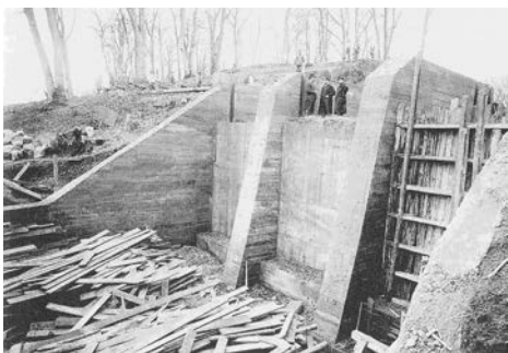
Krigsoverløbet ved Dæmning I - syd for Ermelunden - under opførelse 1886
