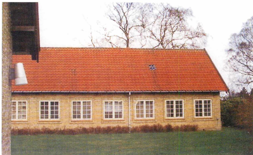
Ældreboliger i Nærum. Billedet er taget i februar 2008, hvor husene venter på at de sidste beboere flytter ud inden nedrivningen. Historisk Arkiv.
